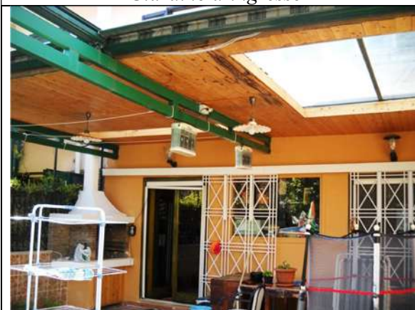
Area coperta giardino retrostante
